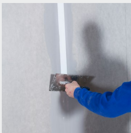
Schritt 4: Fuge nochmals mit Drystar-Filler spachteln
