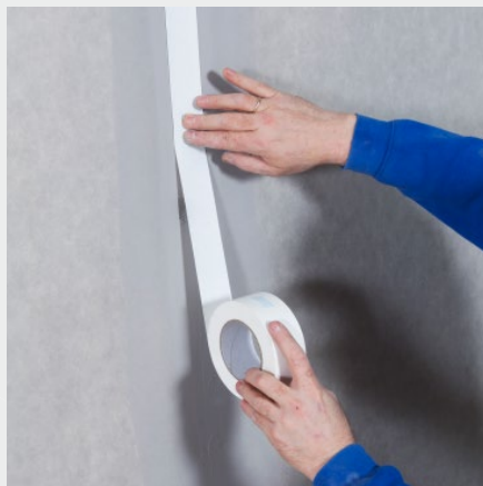
Schritt 2: Knauf Fugendeckstreifen Kurt einlegen
