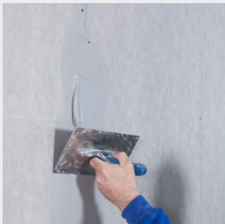
Schritt 1: Fuge mit Drystar-Filler füllen
